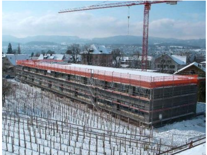
Abbildung 1 Der Bau des Klassentraktes im Februar 2007
